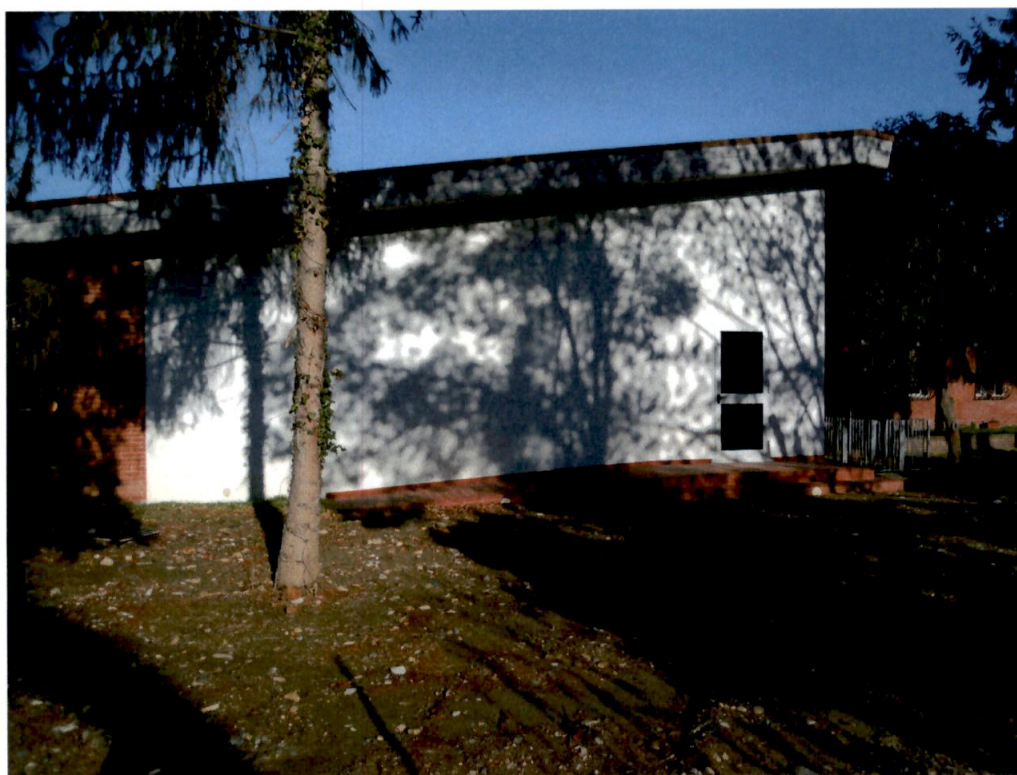
Foto 4 – Nuova porta esterna di accesso all'ampliamento con scivolo
