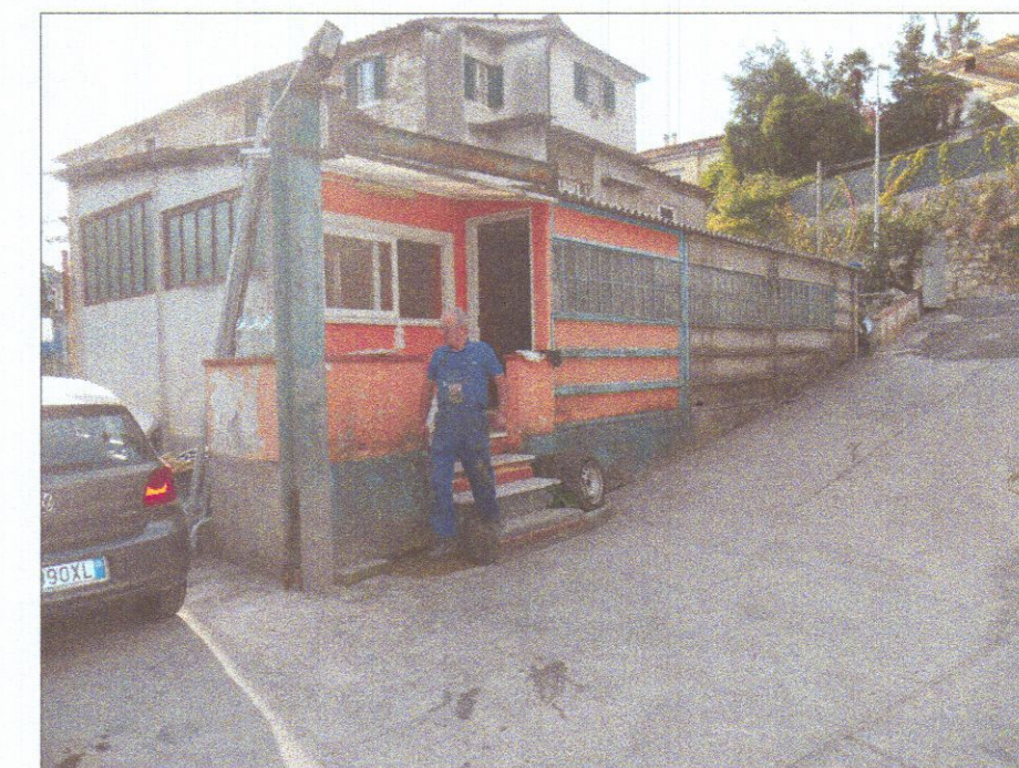
FOTO FABBRICATO DA DEMOLIRE
