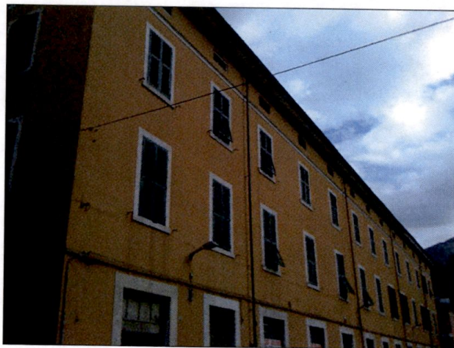
Fronte lato est
