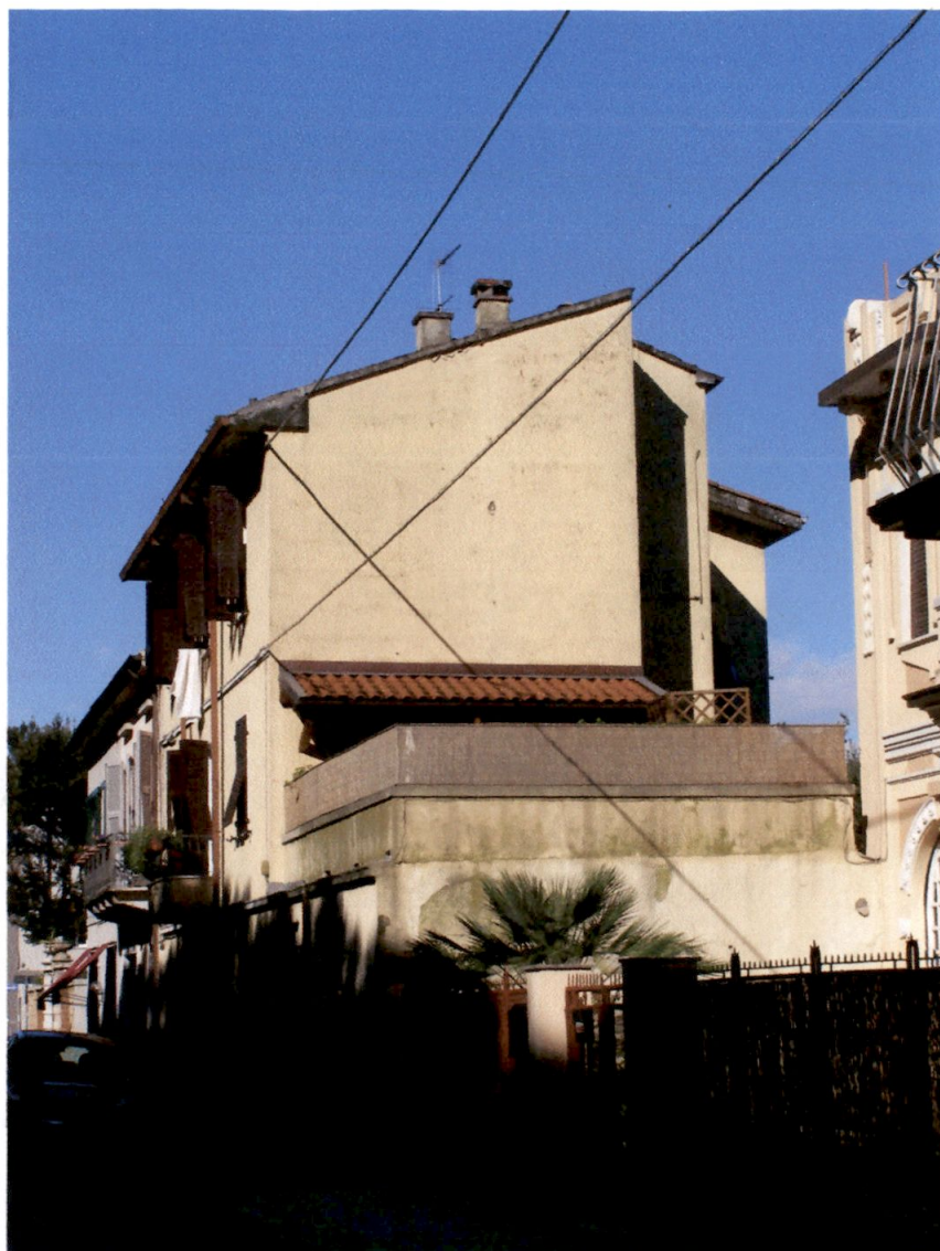
Foto n°2 – Facciata su lastrico solare
