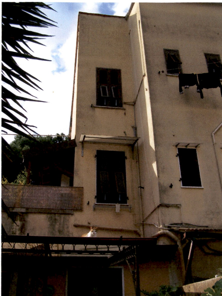
Foto n°3 – Facciate interne oggetto di intervento
