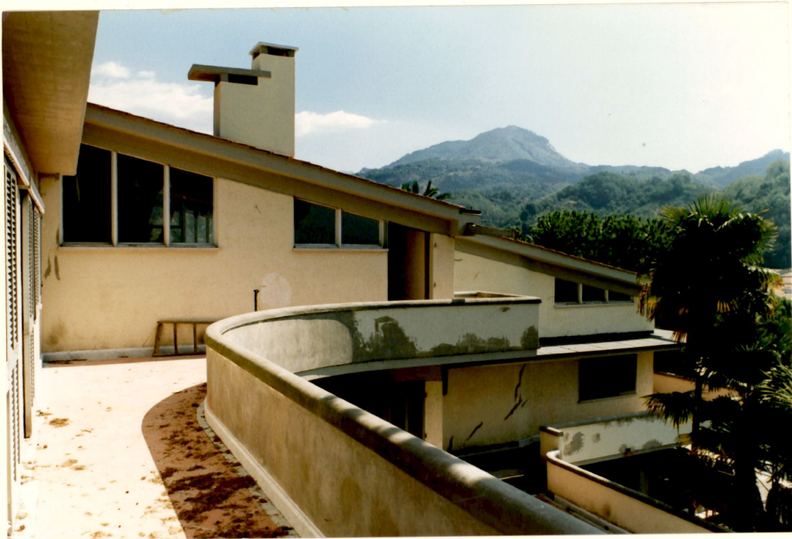
Lato ovest opposto del primo camera
