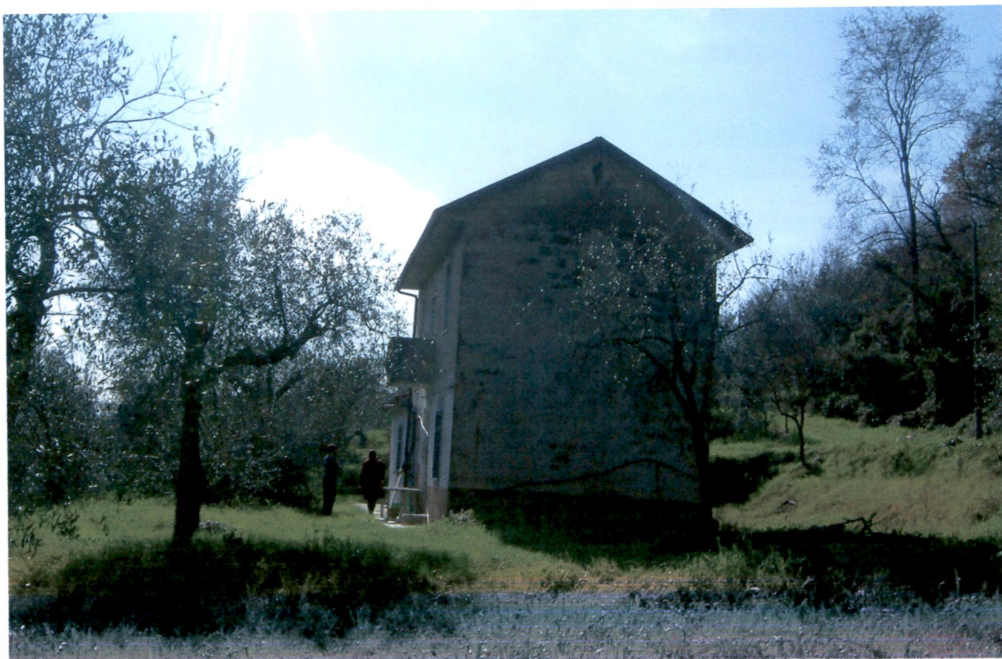
Foto n° 1- Vista lato nord ovest
