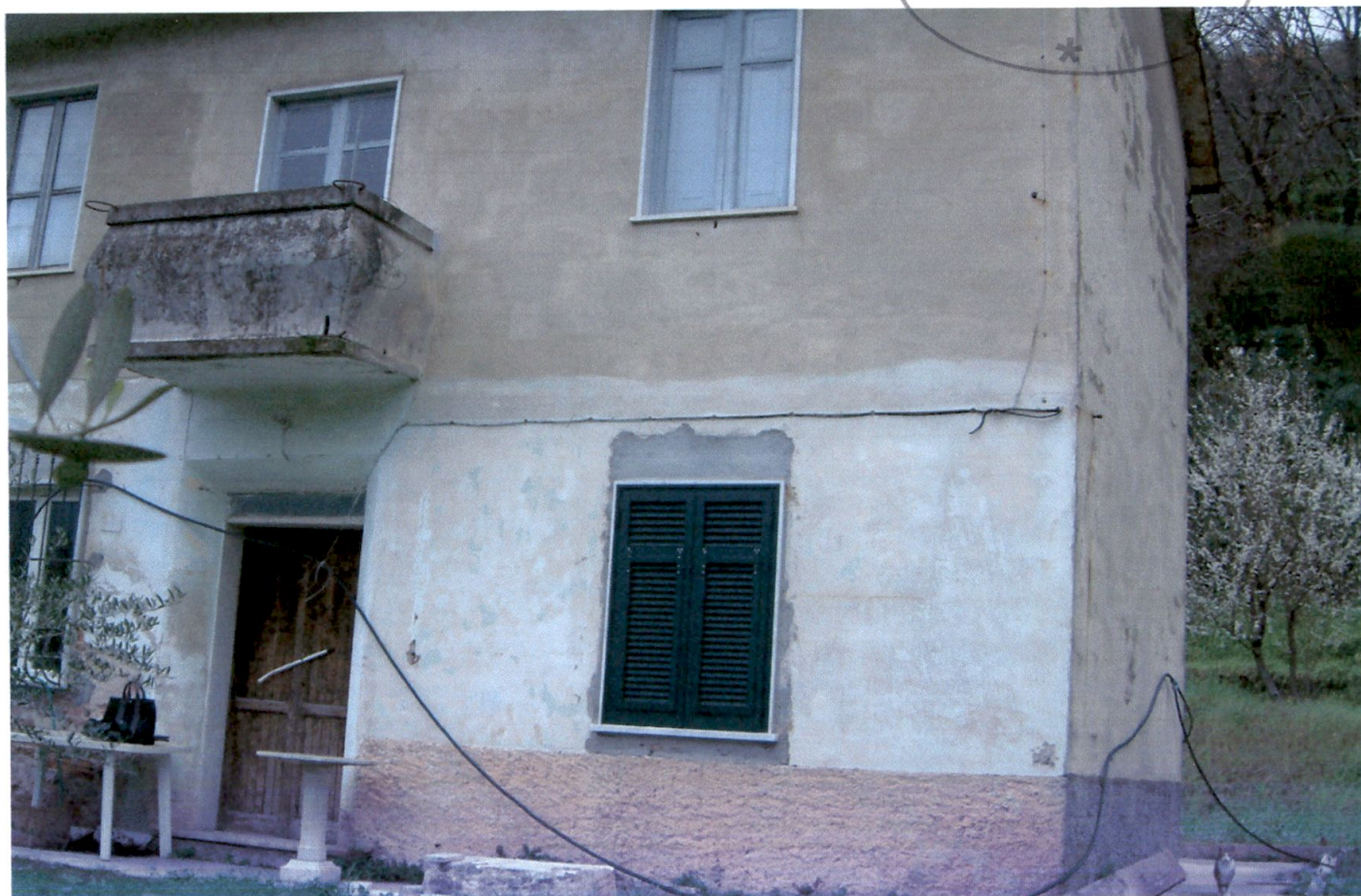
Foto n° 2 - Vista lato nord est
