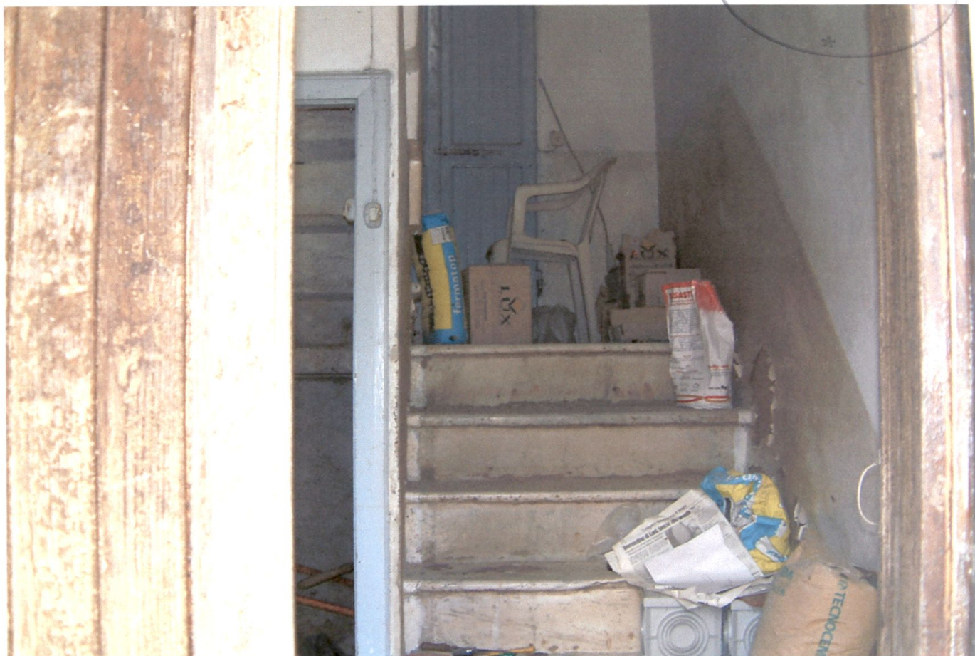
Foto 8 - Vista rampa d'ingresso
