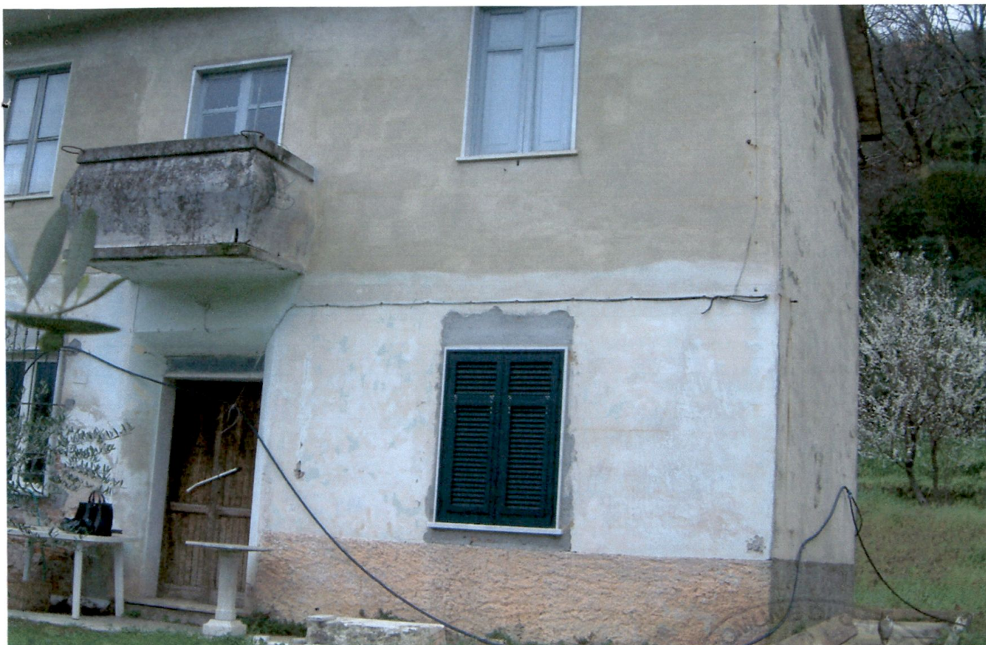
Foto 1 - Particolare prospetto nord-est
