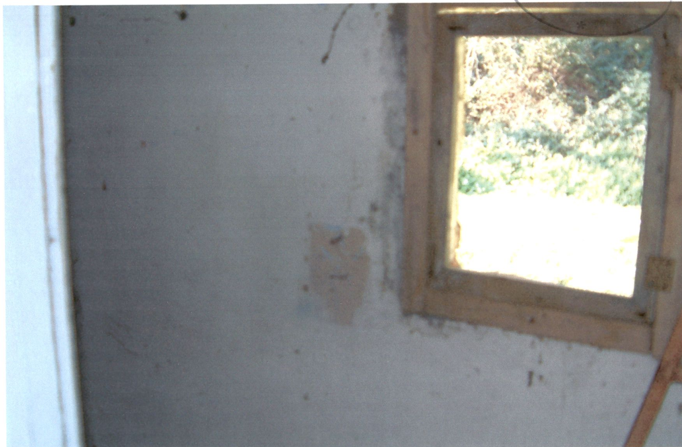
Foto 10 - Vista finestra wc ultimo piano
