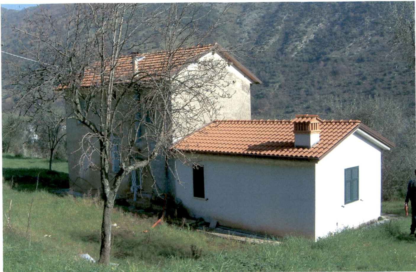
Foto 3 - Vista prospetto sud-ovest
