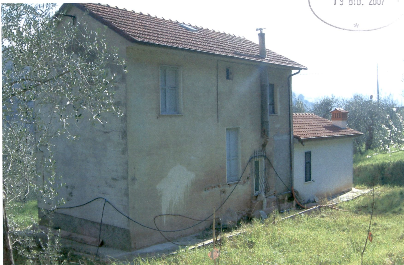
Foto 4 - Vista prospetto sud-ovest
