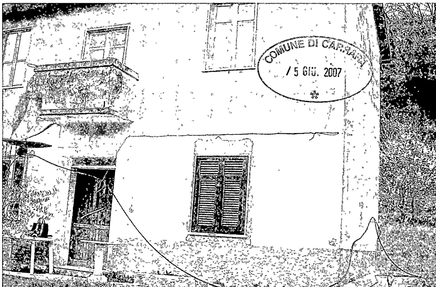
Foto 1 - Particolare prospetto nord-est
