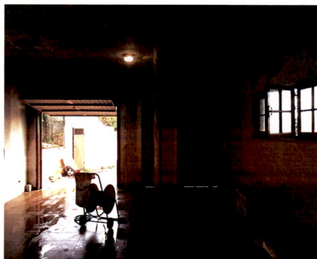
VANO CANTINA PIANO TERRA
