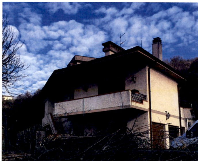
FACCIATA SUD E OVEST
