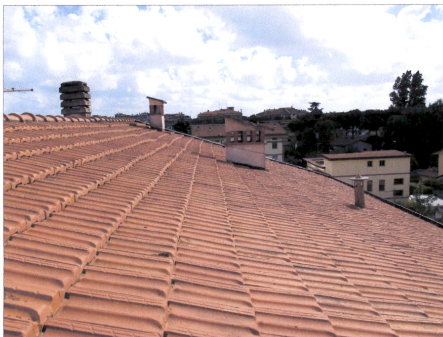
FOTO N. 4-5401: VISTA COPERTURA VERSO SUD
