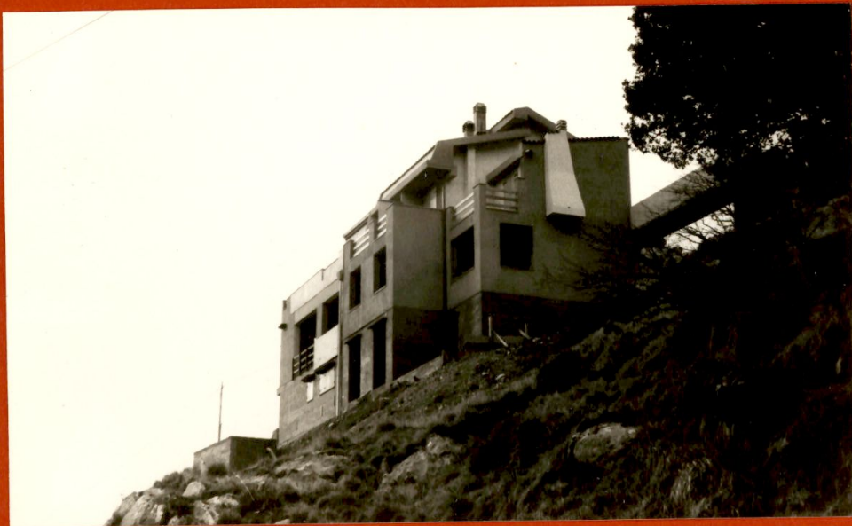
L'INTERO FABB. "A" VISTO DALLA PARTE BASSA DEL TERRENO
