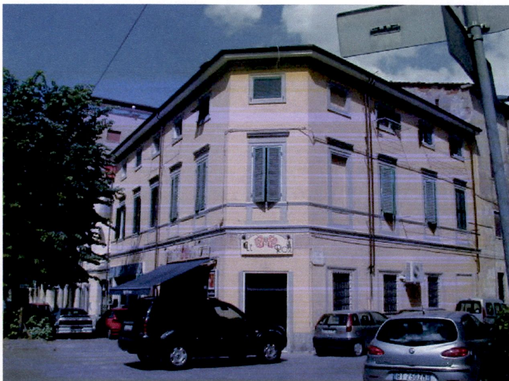
Foto 1 – prospetto su viale XX Settembre fotografia Insieme
