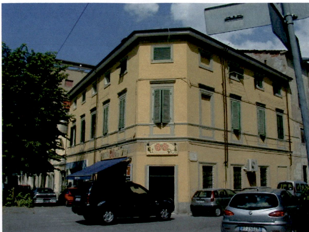
Foto 1 – prospetto su viale XX Settembre fotografia Insieme
