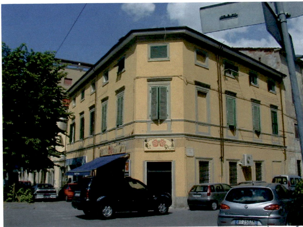
Foto 1 – prospetto su viale XX Settembre fotografia Insieme
