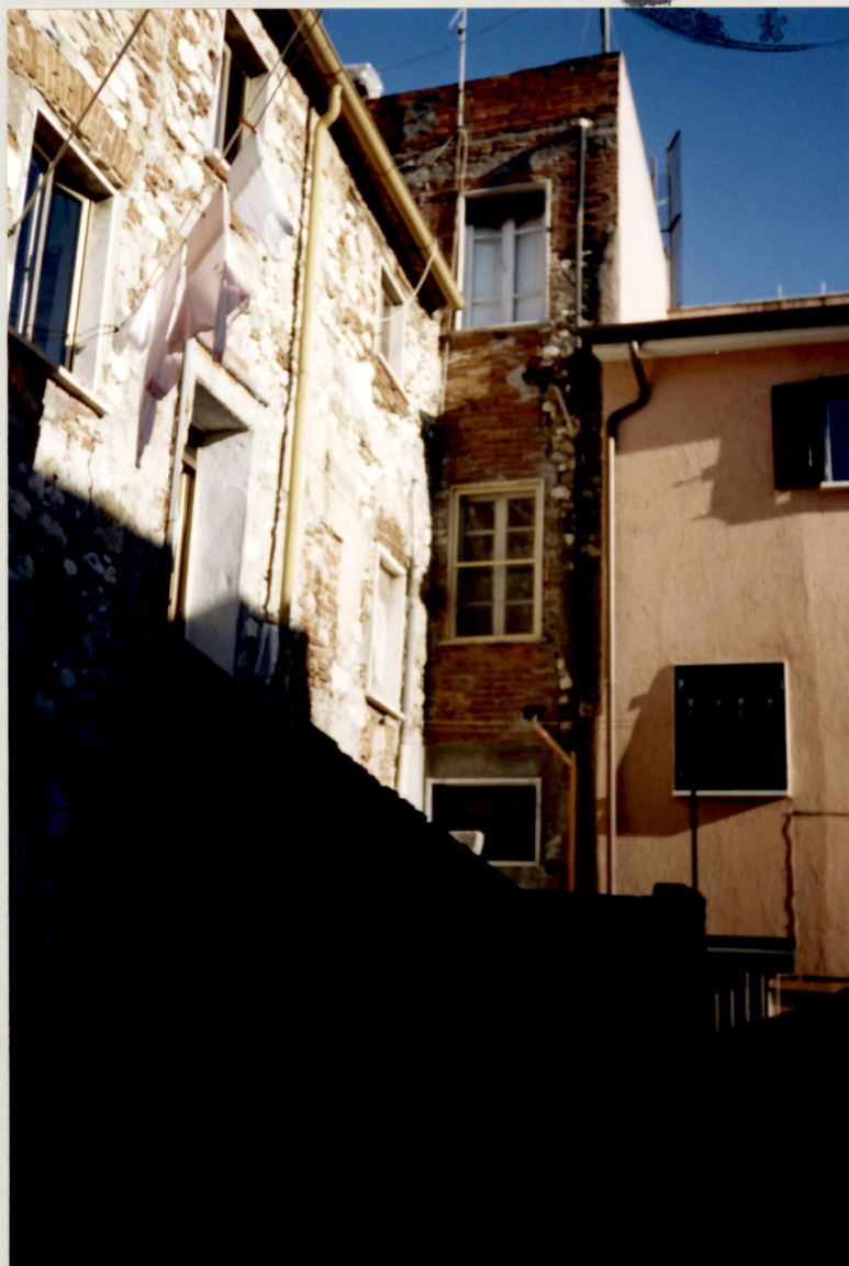
Vista prospetto lato Sud - Ovest ↑
