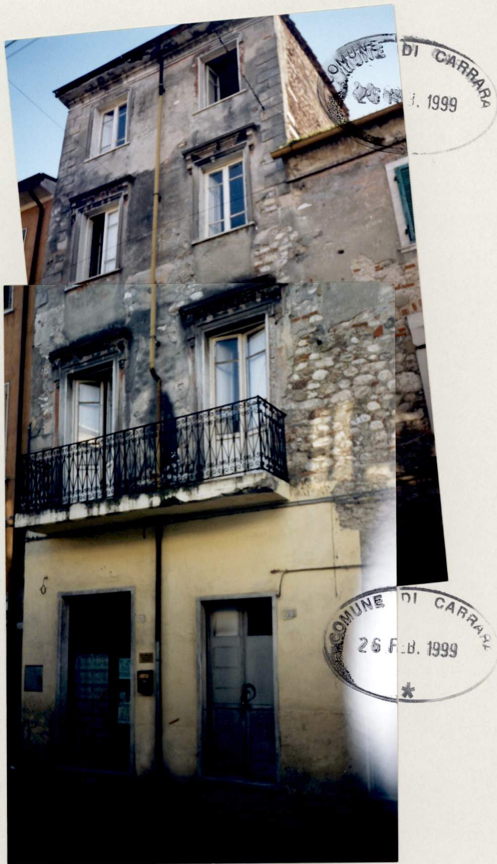
Vista prospetto lato Nord ↑
