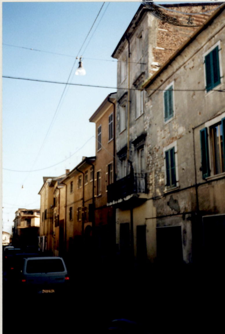
Vista prospetto lato Nord
