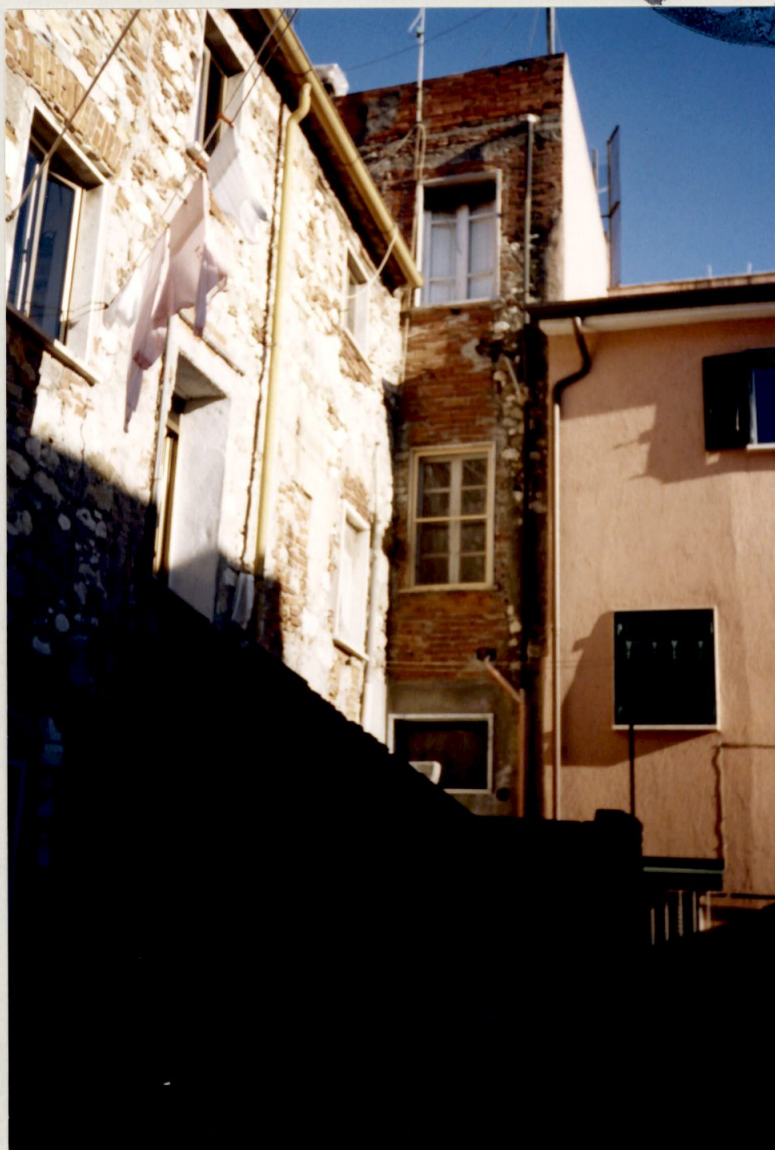
Vista prospetto lato Sud - Ovest ↑
