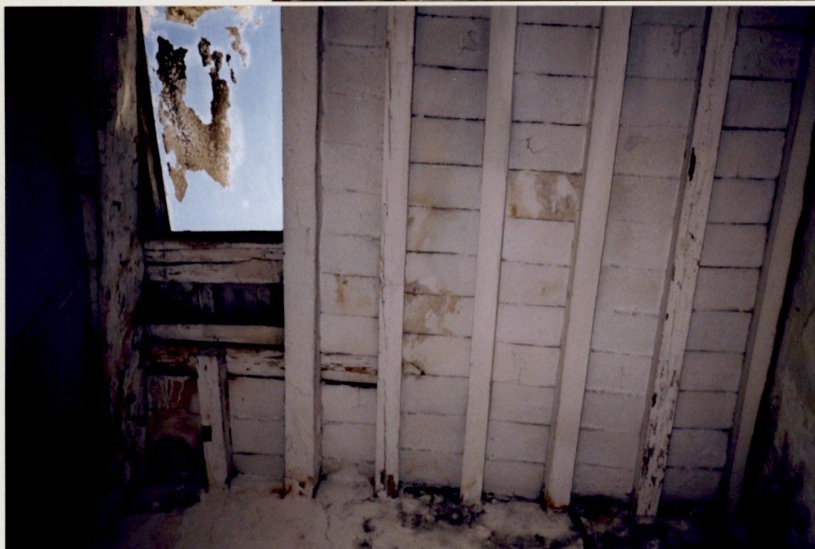
Vista particolare copertura
