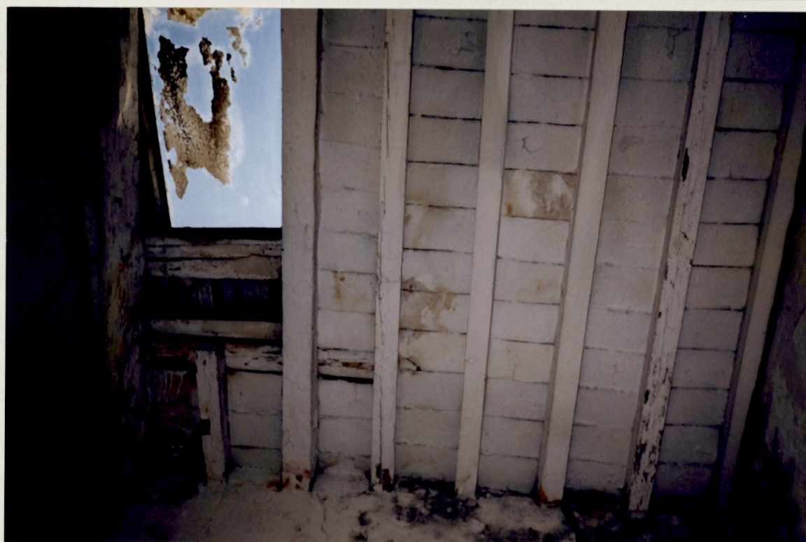
Vista particolare copertura
