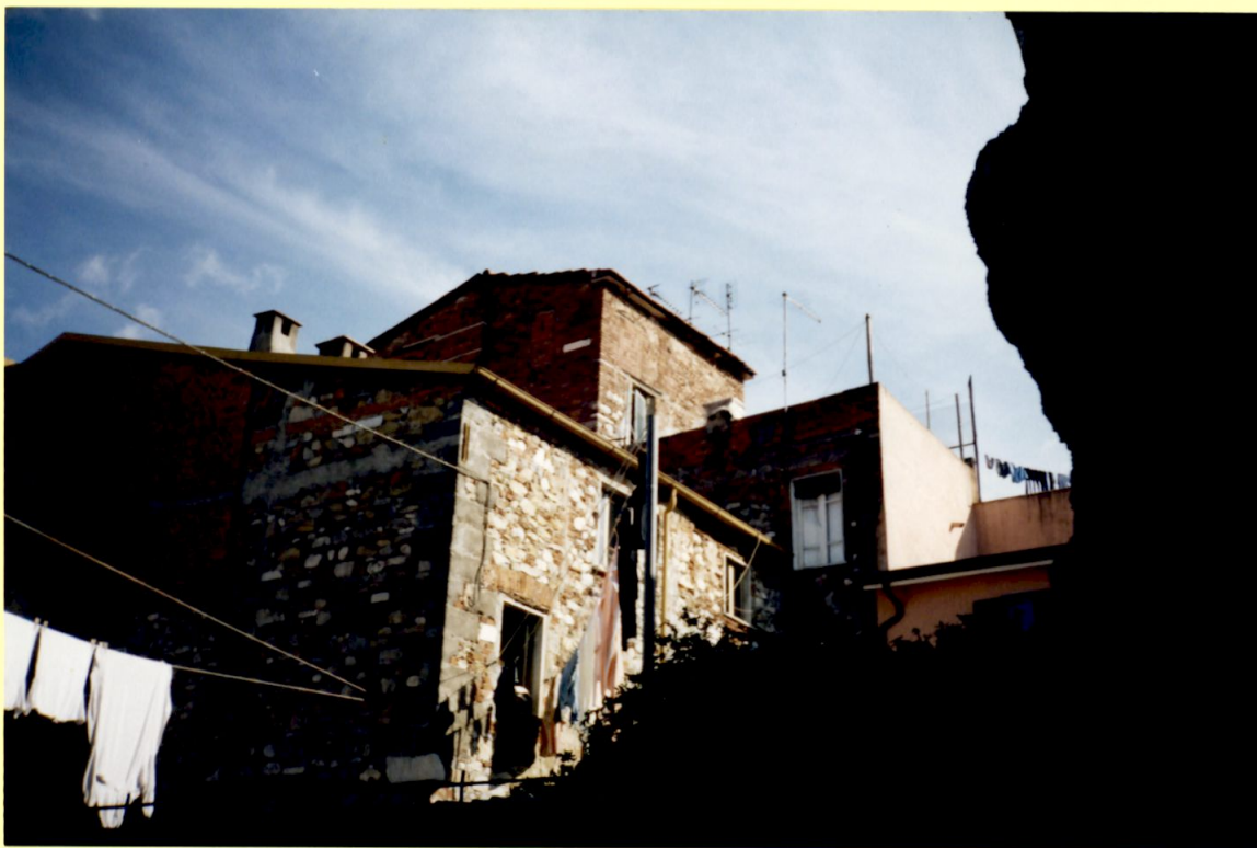
Vista prospetto lato Ovest ↑
