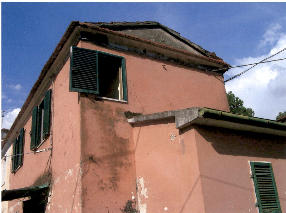
Foto N° 3 : Prospetto Lato Sud.
