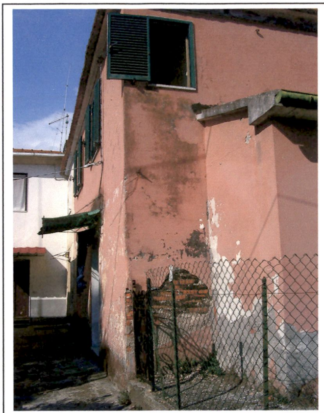
Foto N° 1 : Prospetto Lato Ovest.
