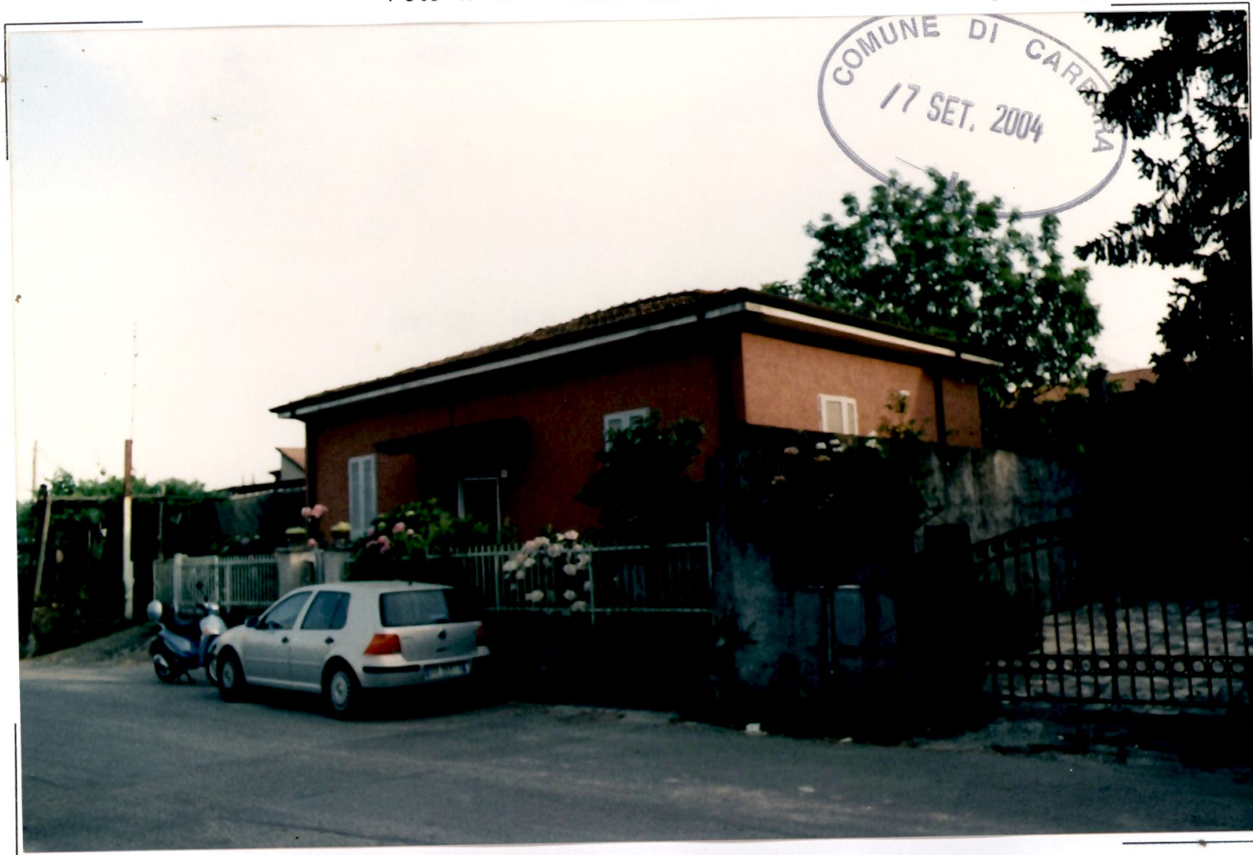
Foto n° 1 – Vista del fabbricato da Via Turigliano (Lato monti)
