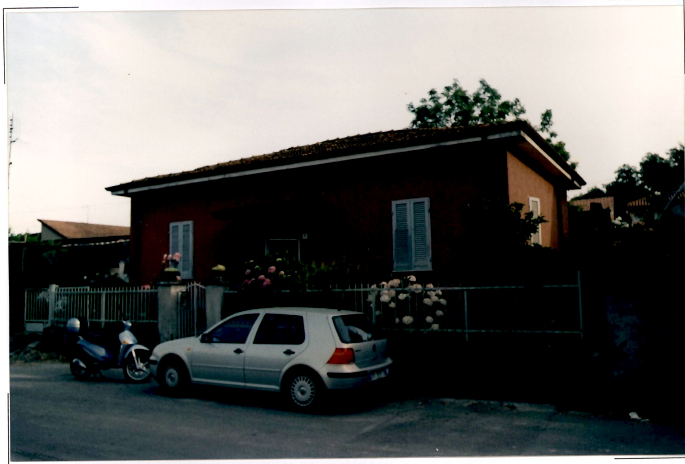
Foto n° 2 – Vista del fabbricato da Via Turigliano (Lato monti)
