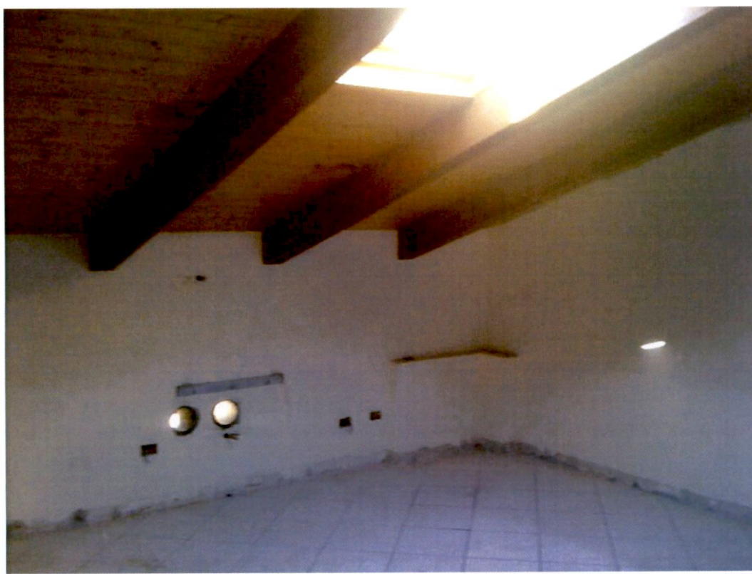
foto n. 6 – vista interna del sottotetto
