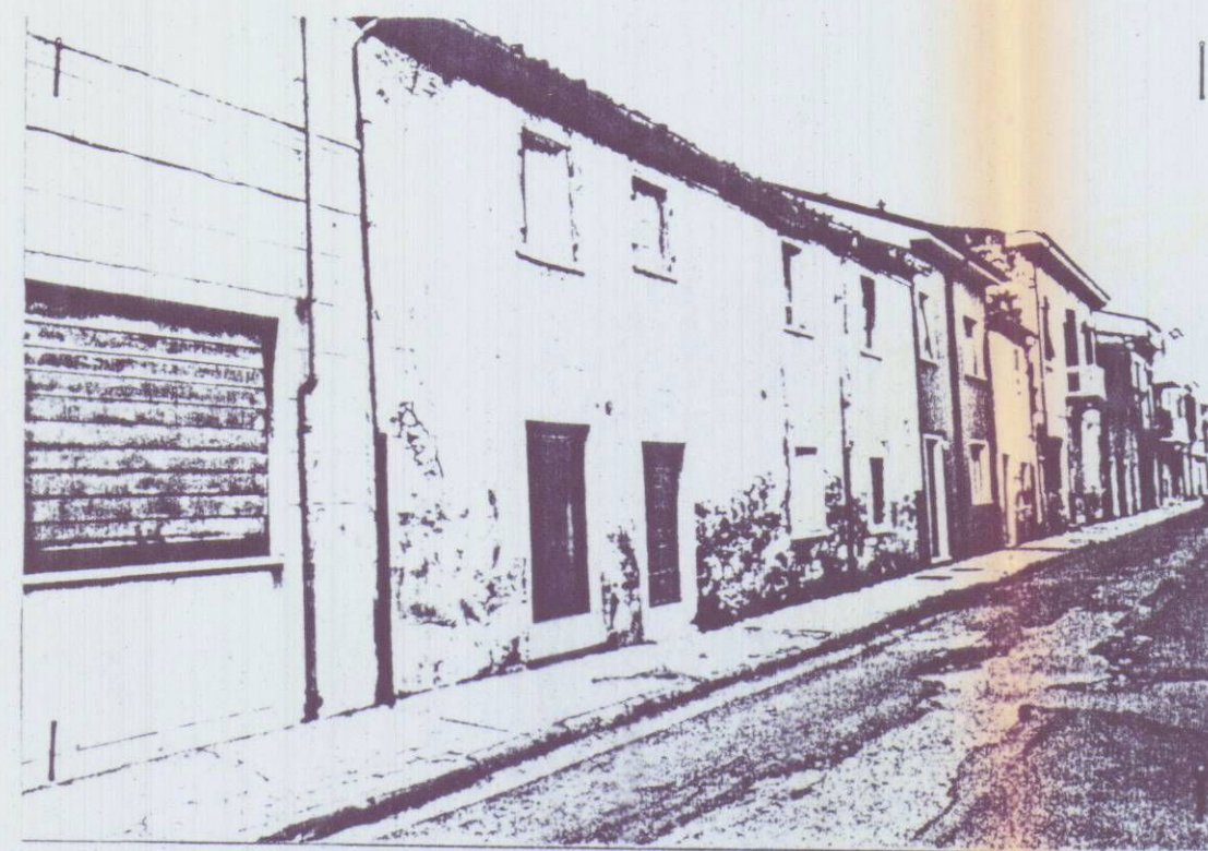
SITUAZIONE PRIMA DELL'INTERVENTO
