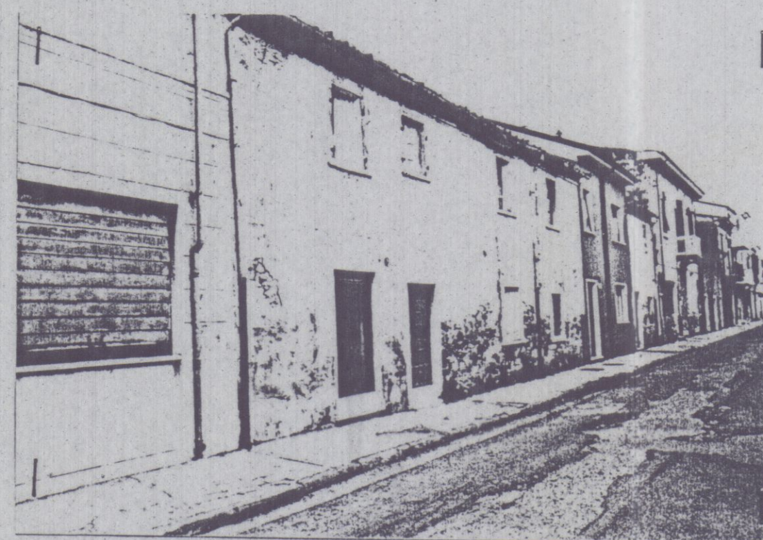
SITUAZIONE PRIMA DELL'INTERVENTO
