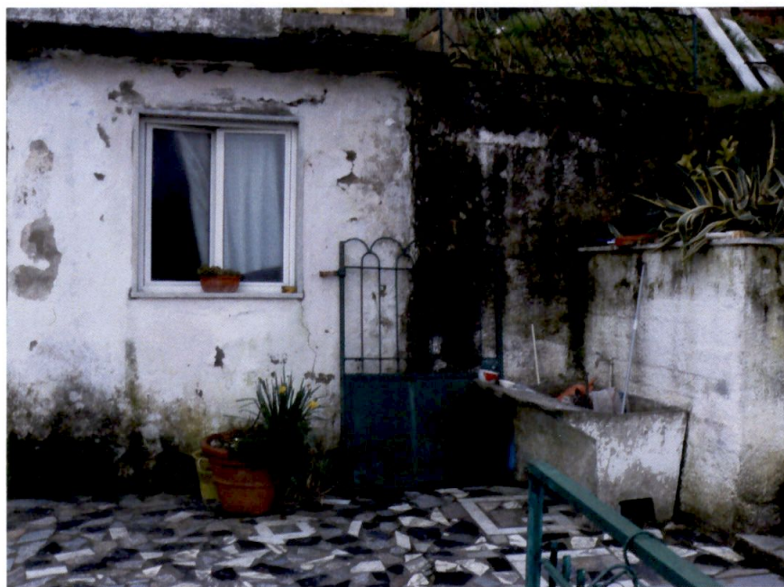
Foto 9 - Attuale Bagno esterno -
