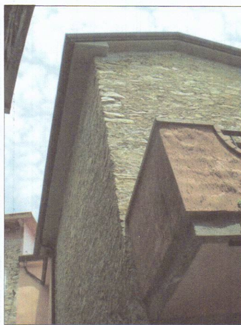
ripresa prospetto sud/ovest
