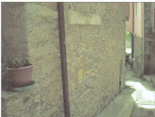
ripresa prospetto ovest
