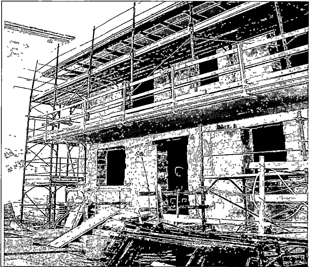
foto n°9 – facciata principale vista lato mare - 10 FEB. 2010
