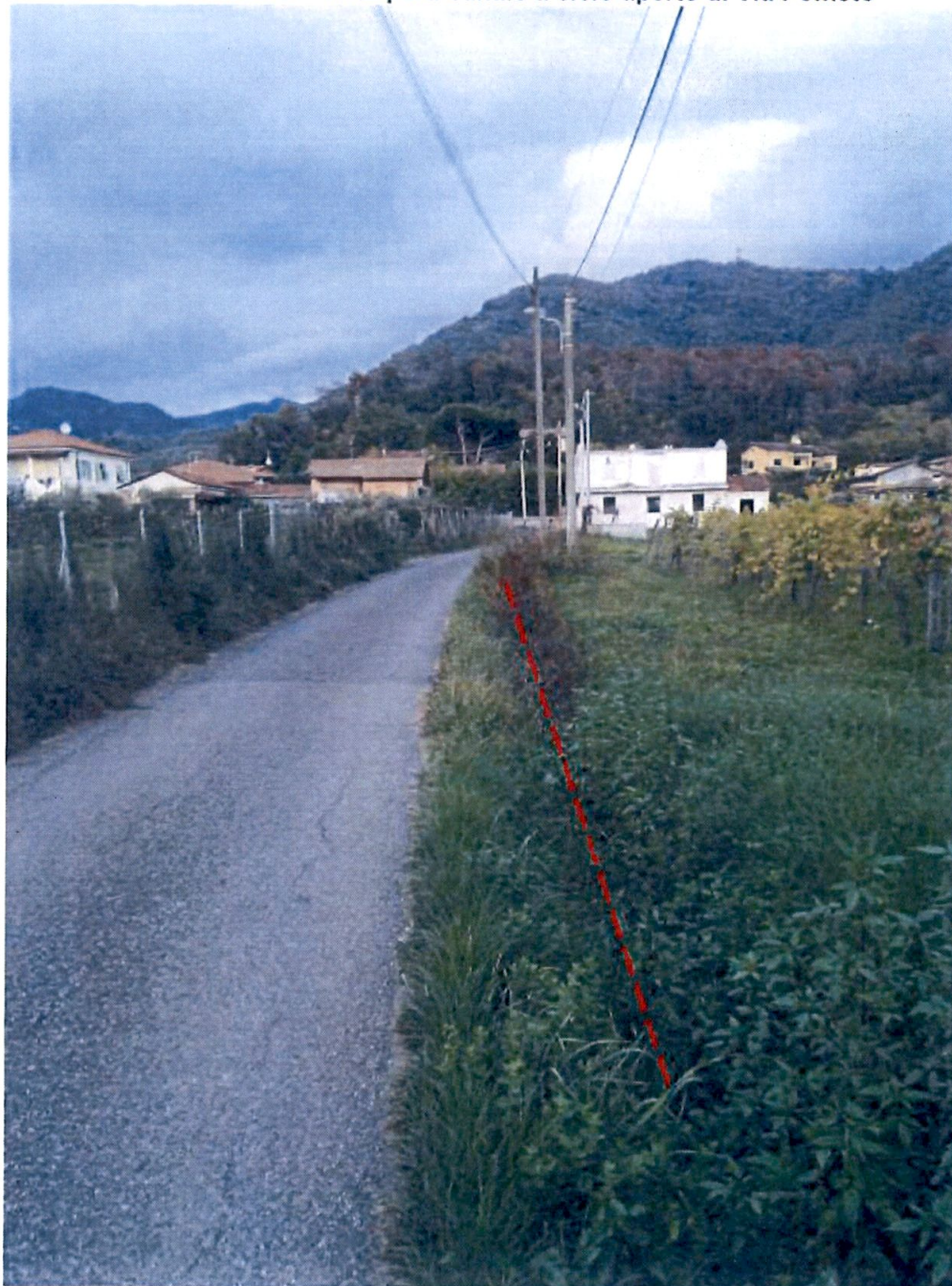
Foto n. 3 – vista parti canale a cielo aperto di Via Pometo
