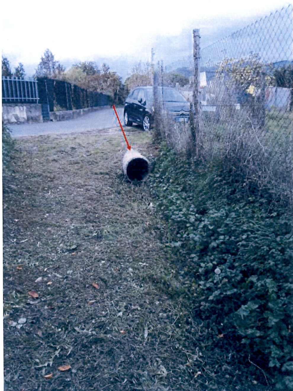
Foto n. 2 – vista sbocco a valle di Via Pometo
