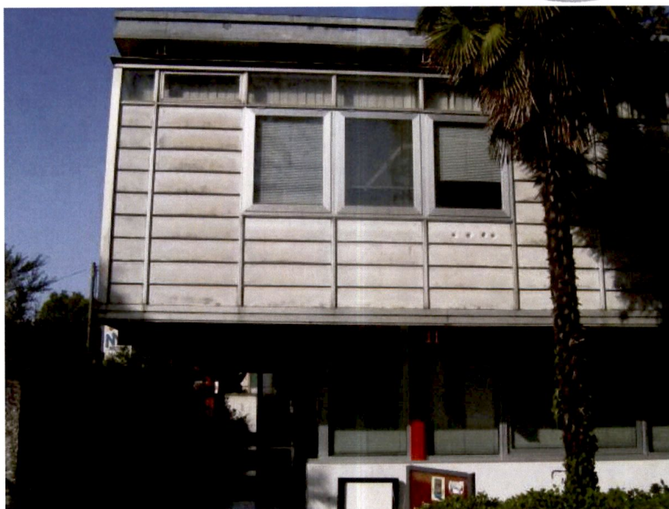
foto . Prospetto verso monte
