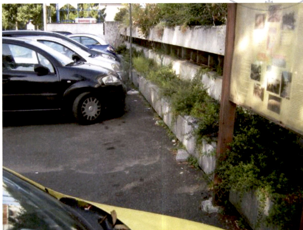
Foto4. Prospetto su Viale XX Settembre. Parcheggio e fioriera.
