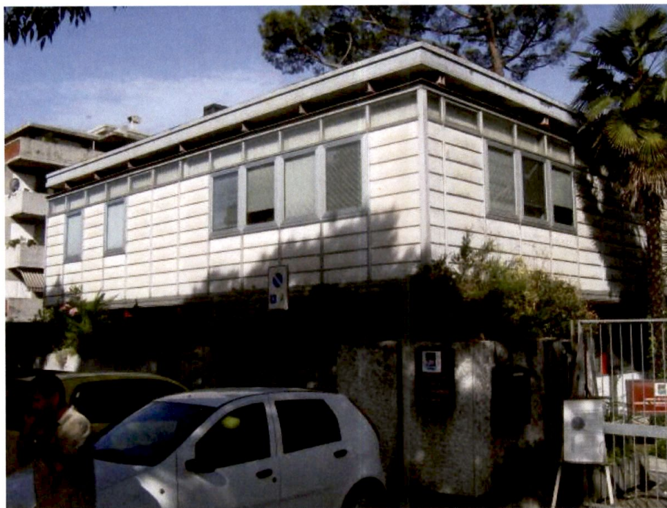
foto 1. Prospetto su Viale XX Settembre
