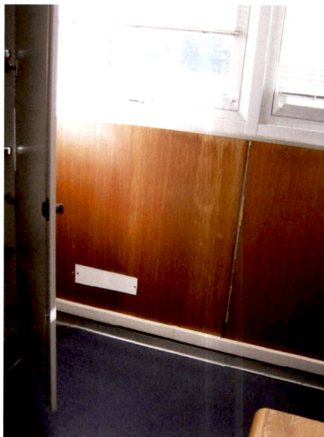
foto 14. Interno al piano primo (ufficio)
