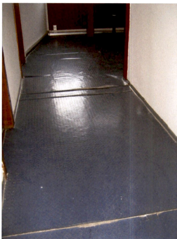
foto 10. Corridoio piano primo.
