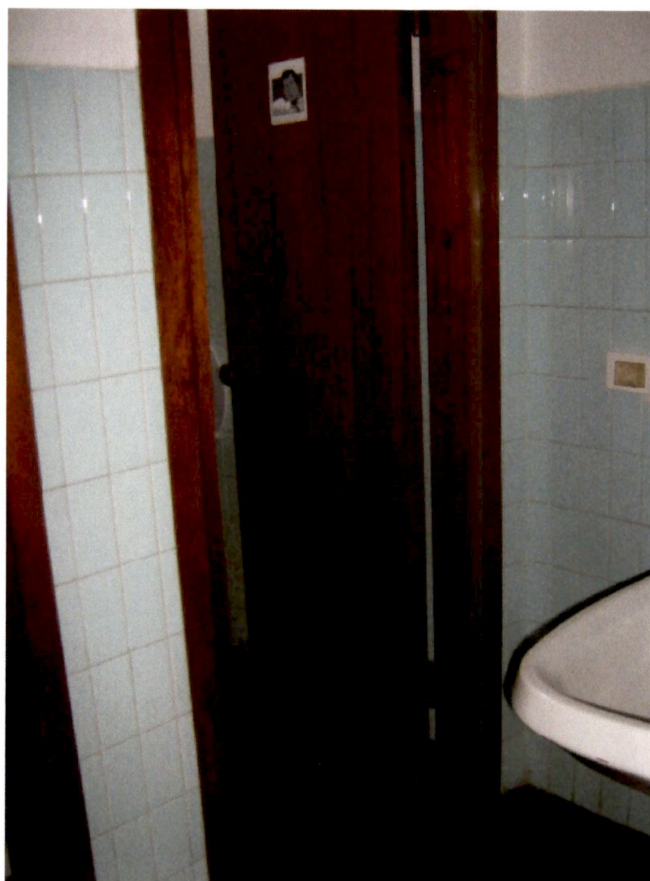
foto 11. Antibagni al piano primo
