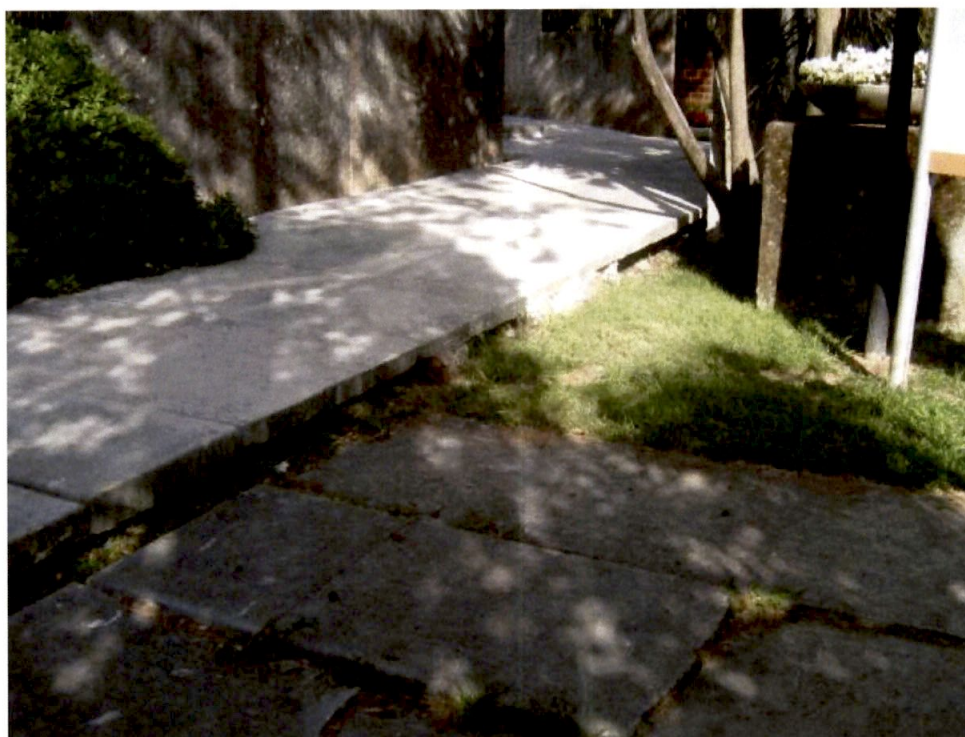
foto 3. Barriera architettonica esterna. Gradino fra accesso pedonale e marciapiede perimetrale del fabbricato.
