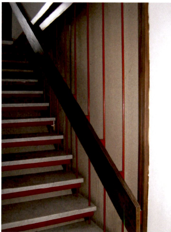
foto 9. Scala di collegamento piano terra – piano primo.
