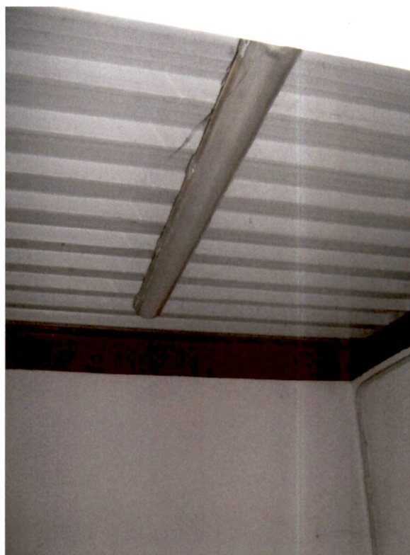
foto 7. Solaio da tagliare entro le strutture portanti (travi) per collocare corsa montacarichi.
