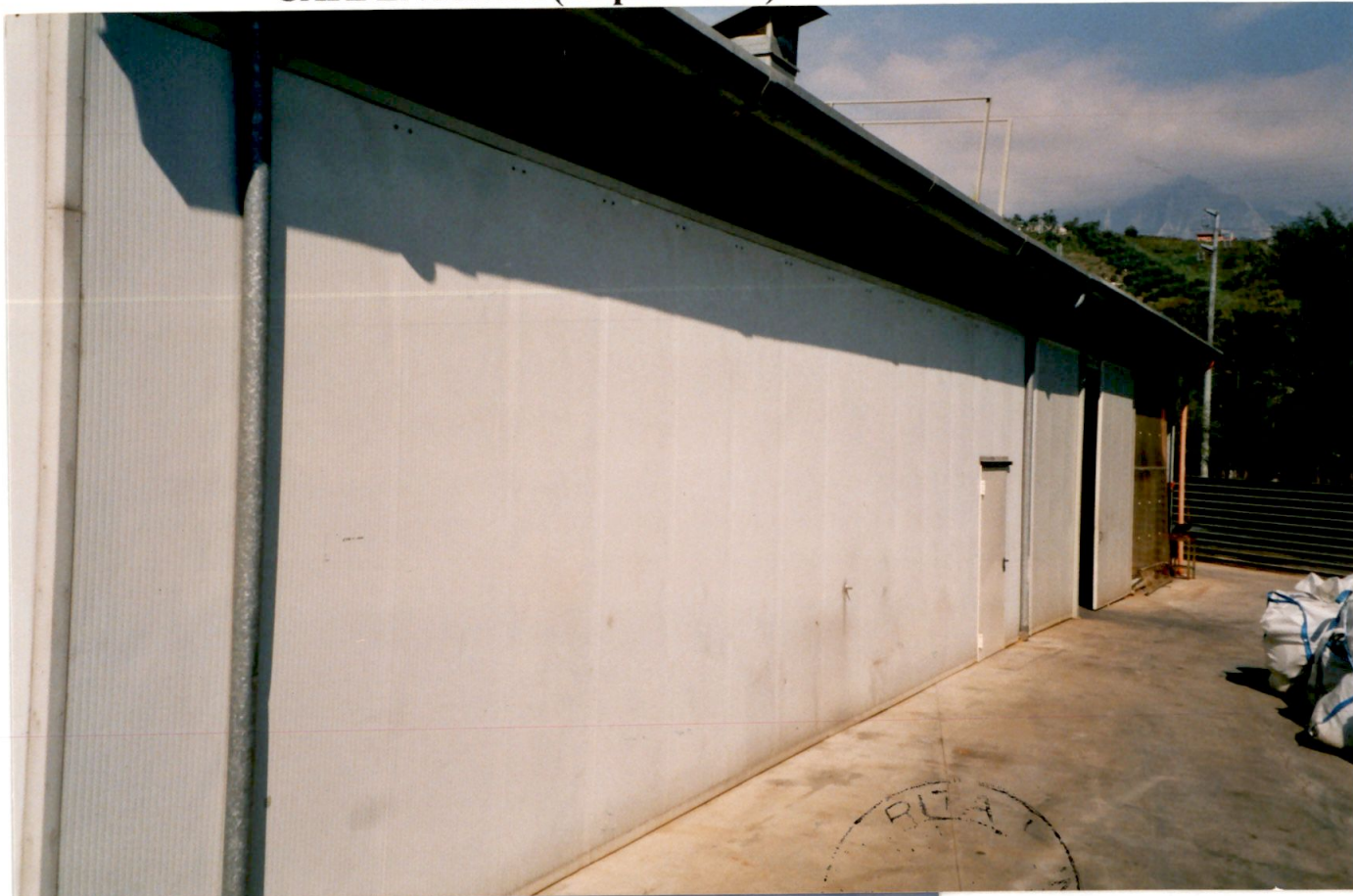
CARPENTERIA (ampliamento) - vista lato levante
