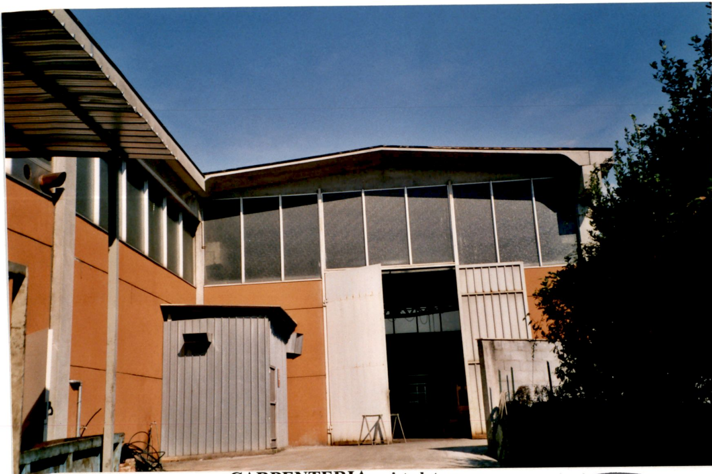
CARPENTERIA - vista lato mare
