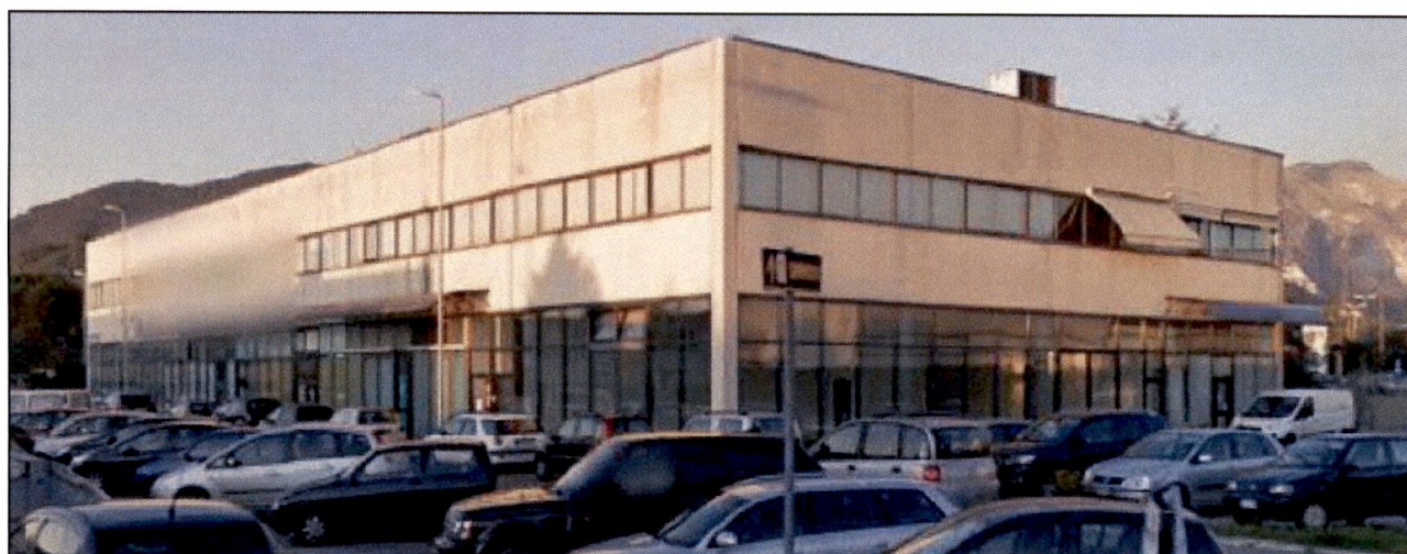
Foto 2: Prospetto dell'edificio antecedente l'incendio del 29 settembre 2015
