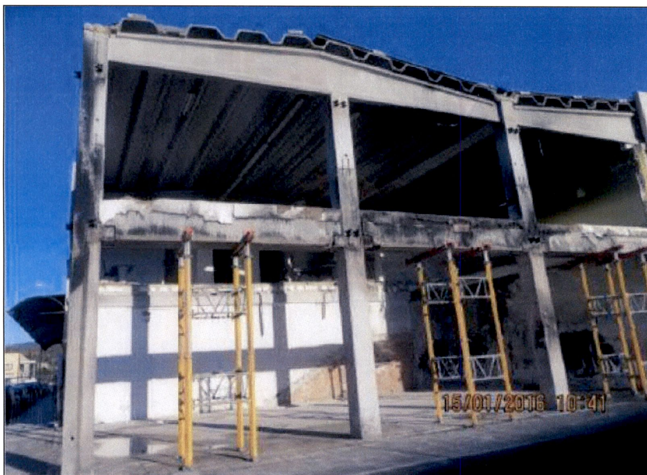
Foto 4: Prospetto dell'edificio a seguito dell'intervento di bonifica post-incendio
