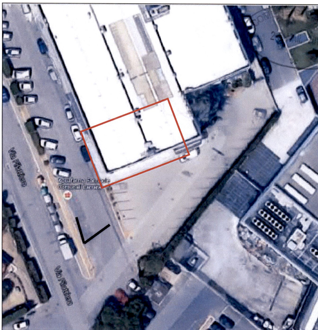
Foto 1: Vista aerea della porzione di edificio oggetto di intervento.
