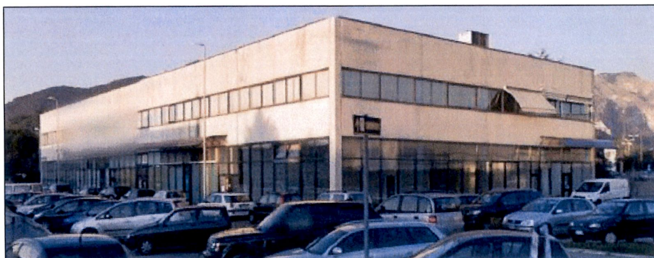
Foto 2: Prospetto dell'edificio antecedente l'incendio del 29 settembre 2015
